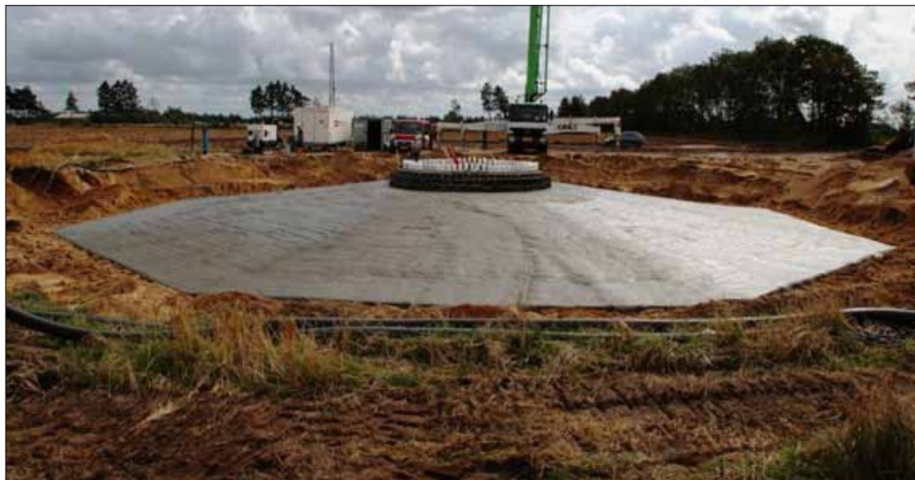
Figur 4.5 Færdigstøbt vindmøllefundament, kilde: Bestenergy.dk
